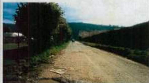
Fotografía No 2. Se observa la calle 192 vía de ingreso al Plan Parcial No. 10 "El Rosario", la cual se encuentra pavimentada en regular estado.
