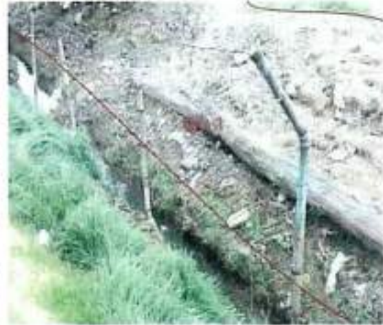
Foto 8 Zanjas Utilizadas Para la Delimitación de los Predios y Para el Drenaje de las Aguas Lluvias. Se Observa en la Margen Derecha la Acumulación de Rellenos Antrópicos Gra1
